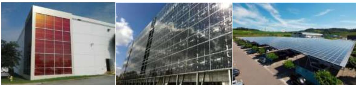
**Photovoltaïque organique (à gauche), intégré en façade (au milieu) et en ombrière (à droite)**
