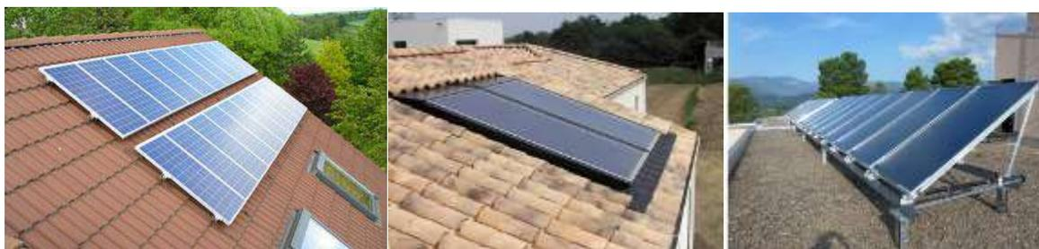
*Capteurs solaires thermiques sur rails (à gauche), intégrés (au milieu) et non-intégrés sur plots de fixation (à droite)*
